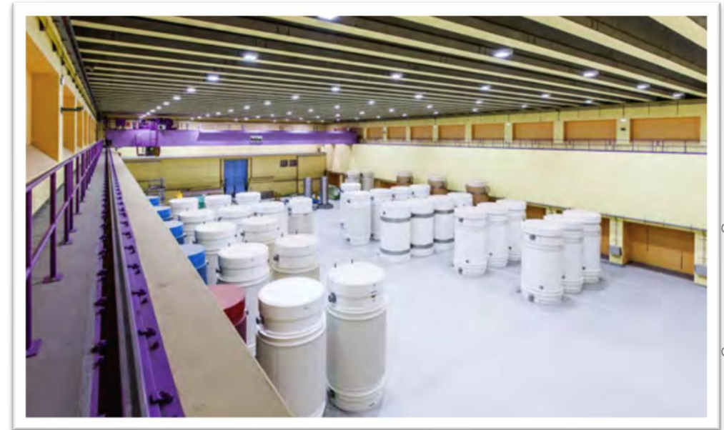
ZWILLAG Zwischenlager Würenlingen AG
